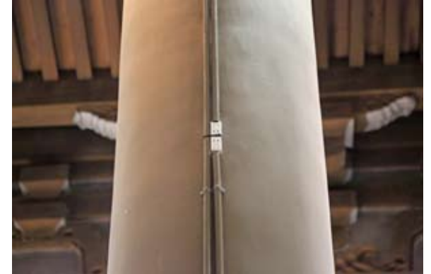
近柱電源.JPG
